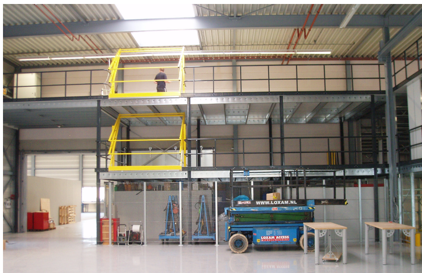
ME250 dubbeldekker vloer met kantelhekken
